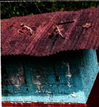
Foto 1: Se observa el estado deteriorado del techo de las letrinas.
