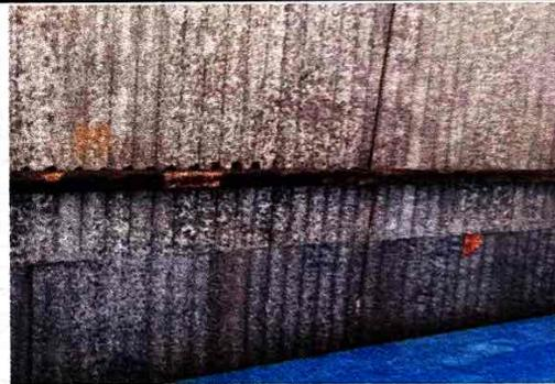
Foto 4: Se observa el mal estado de las costaneras que sostienen el techo.
